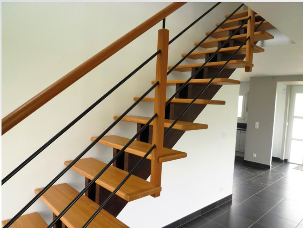
*Assemblage traditionnel : à tenons et mortaises*
